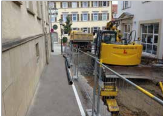
Tief- und Straßenbau
